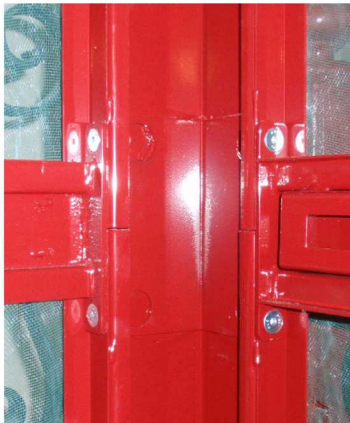
Detalle de la unión de pilares y traviesas
